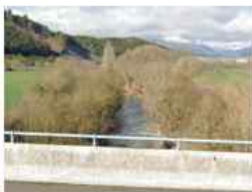
Vista de la Unidad desde el puente sobre la NA-30.
