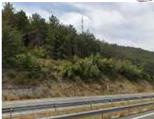
Vista de la unidad desde la autovía A-15
