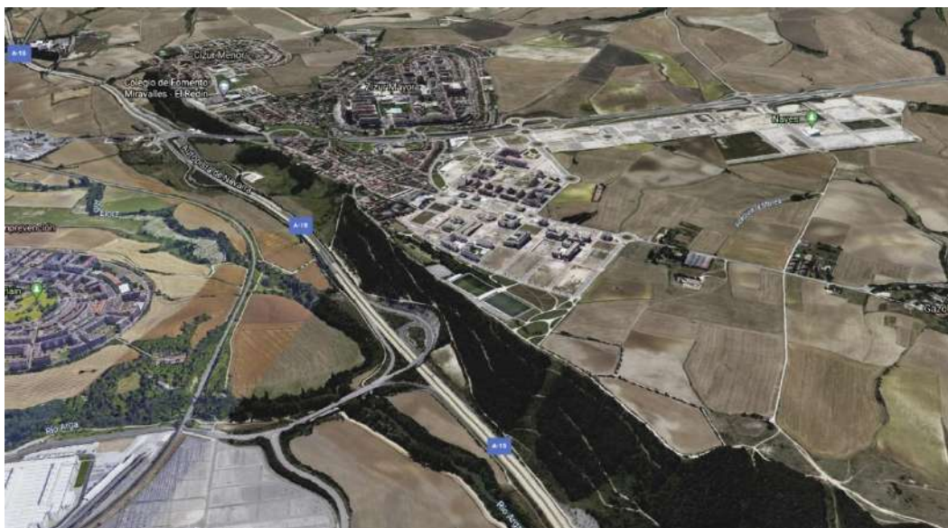
Panorámica del término municipal en dirección W-E con talud estructural que divide dos partes claramente diferenciadas.
