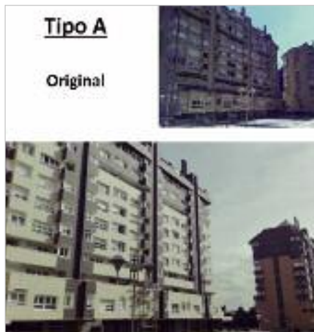
PIG Torres tipo A: cuenta ya con el modelo que se ha ejecutado en los Bloques A2 y A3 (del equipo de GC edificación).
